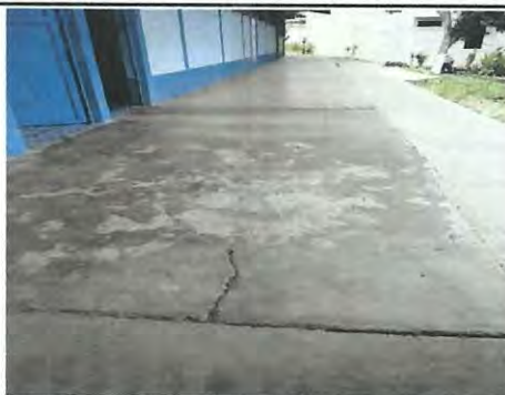
Foto 1: Se mejorará y se instalará piso a granito en corredor
